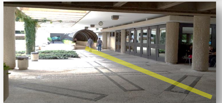
Recorrido de tubería
